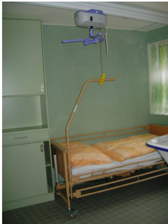
Deckenlifter in Kombination mit Schienensystemen bieten den Vorteil, dass mehrere Zimmer miteinander verbunden werden können und dass eine Bewegung überall hin möglich ist, ungehindert durch Möbel oder Türschwellen. Deckenlifter ermöglichen das Heben und Absetzen von Pflegebedürftigen mit minimalem Kraftaufwand sowie durch leichtes Schieben in der Schiene den Transport vom/zum Bett, Toilette oder Badewanne.
