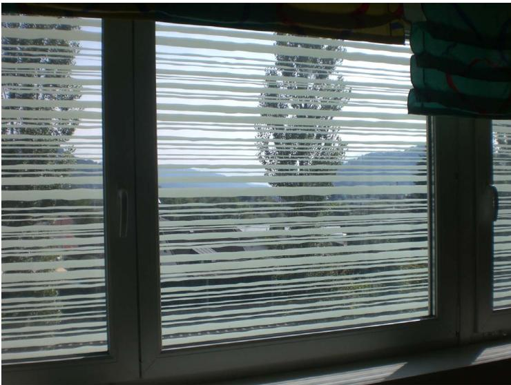
Bei Lichteinfall auf die bedruckte Glasfläche ist der Kontrast wegen auftretender Streueffekte deutlich herabgesetzt, ein Erkennen der Umgebung ist nicht mehr in ausreichender Form gegeben.
