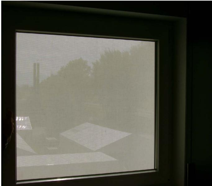
Textilfassade mit technischen Mustern (Produkte der Firma, sowie Firmenlogos) in ca. 20 cm Entfernung, engmaschige Folie mit Mustern (ca. 40 bis 50 % der Gesamtfläche), Kontrast zwischen Musterelement und umgebender Struktur relativ stark, Farbe des Musters innen weiß/grau, außen violett und andere Farbtöne.
