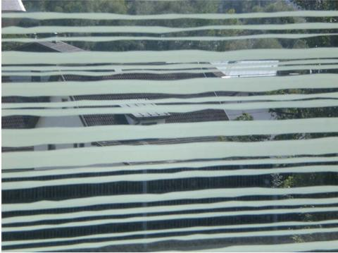
Vorgehängte Fassade aus bedrucktem Glas, Streifenmuster waagrecht verlaufend, jeder Streifen 3 bis 10 cm breit, dazwischen Klarglas etwa 3 cm breit - Kontrast etwa 1:10, Farbe mattweiß.
