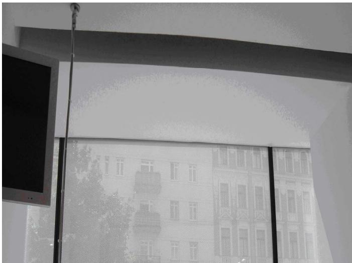
Bei Lichteinfall auf die bedruckte Glasfläche ist der Kontrast wegen auftretender Streueffekte deutlich herabgesetzt, ein Erkennen der Umgebung im Sinne des § 25 Abs. 5 AStV ist nicht gegeben.
