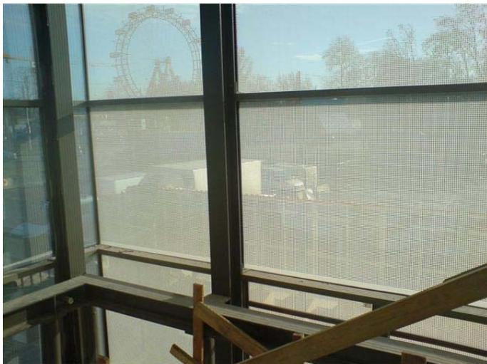
Bei Lichteinfall auf die bedruckte Glasfläche ist der Kontrast wegen auftretender Streueffekte deutlich herabgesetzt.
