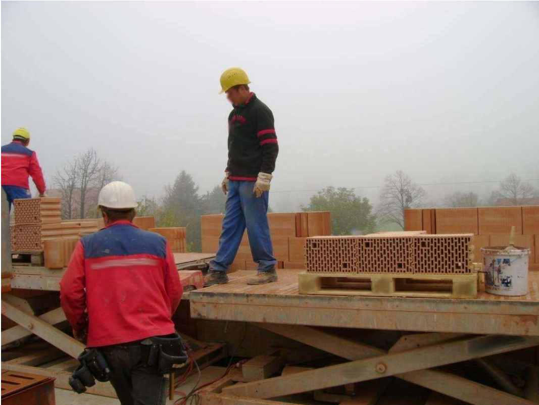
Höhenverstellbarer Scherenhubtisch
