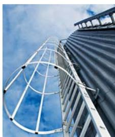
**Festverlegte lotrechte Leitern** - müssen bis 5,0 m Absturzhöhe mit einem Rückenkorb ab 3,0 m und im Endbereich mit einem Ruhebügel ausgerüstet sein. Ab einer Absturzhöhe von mehr als 5,0 m muss eine Rückensicherung ab 2,0 m vorhanden sein.
