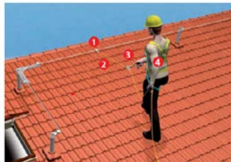
Auffangsystem mit mitlaufendem Auffanggerät einschließlich beweglicher Führung und horizontaler Anschlageinrichtung
